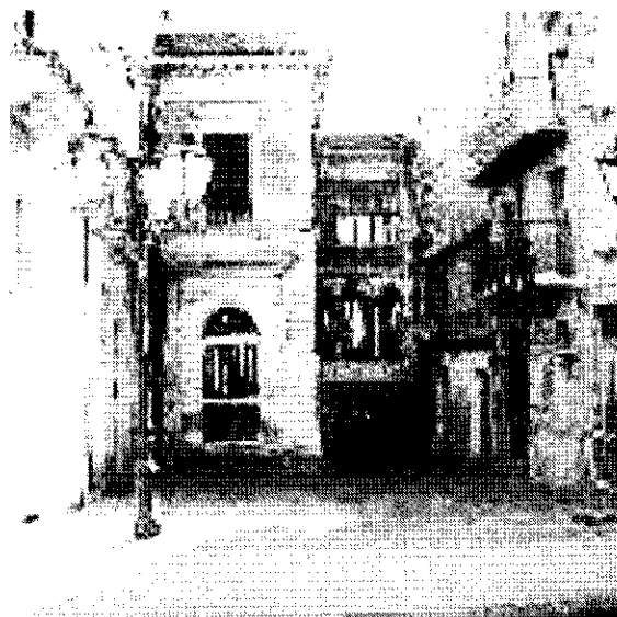
Vista cortile "Arco Litteri"
